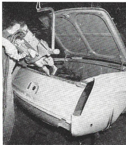
Fig. 97. — Soudage de la tôle formant panneau arrière sur traverse arrière supérieure. Pince ARO.
