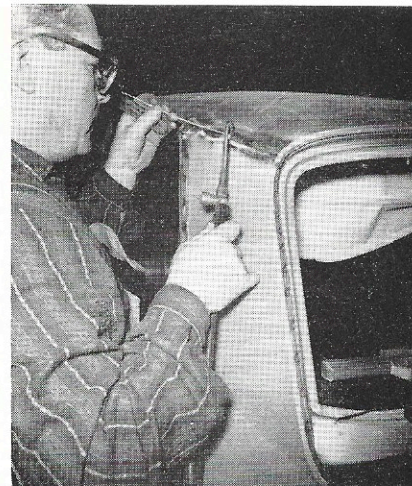
Fig. 65. — Soudage à la soudure oxyacétylénique jonction panneau de custode-pavillon.
